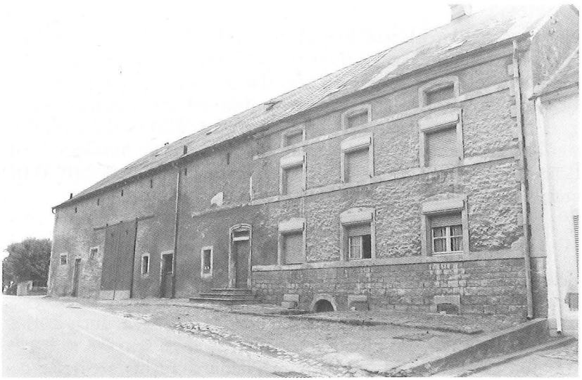
D'Haus „NEIENS“ zu Zolwer an der Enneschtgaass ass 1807 gebaut gin.
