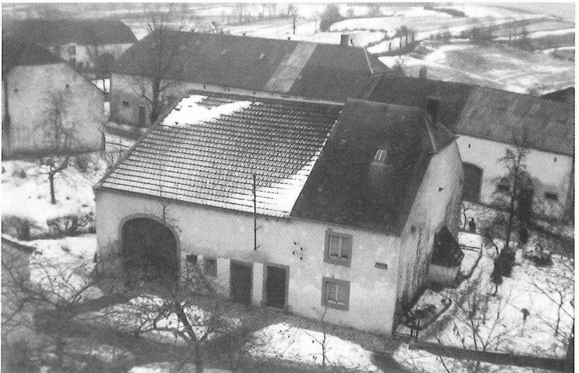
Da war das Dorf noch intakt. Im Vordergrund das Haus Henkes (Jungers), welches heute umgebaut und renoviert ist. Die Höfe dahinter mußten Wohnsilos weichen.
