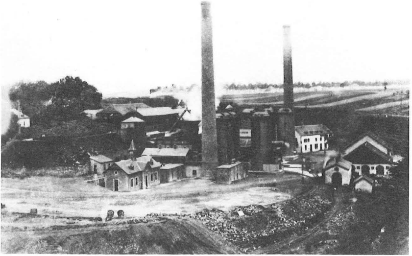
Fig 3, 3bis L'Usine de STEINFORT vers 1900 et 1910.
