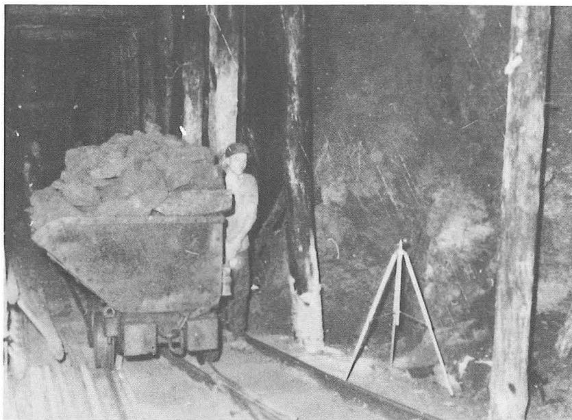
Fig. G, H Un rouleur (Schlepper) évacue un "buggi" chargé.
