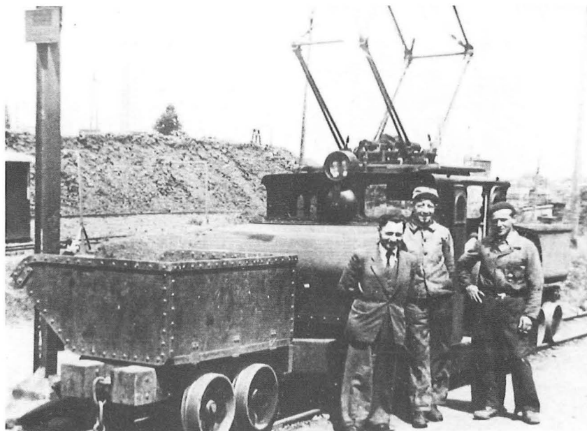
Fig. 22 La locomotive électrique "ENERGIE" (navette mine-quai).
