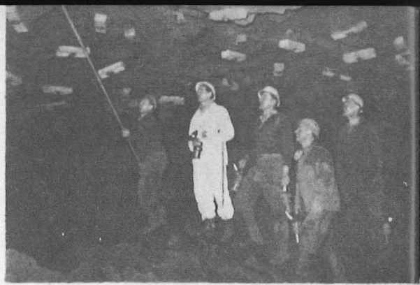
Überall lauert die Gefahr und vorsichtig wird die Decke abgeklopft, um die Arbeiter vor Überraschungen zu sichern.
