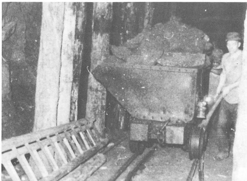
Fig. G, H Un rouleur (Schlepper) évacue un "buggi" chargé.
