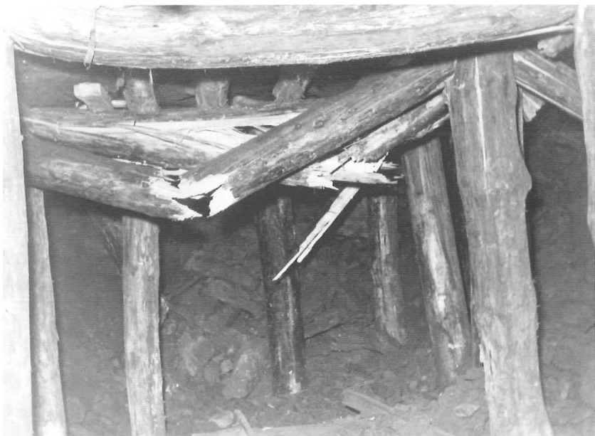
Éboulement d'un chantier.
