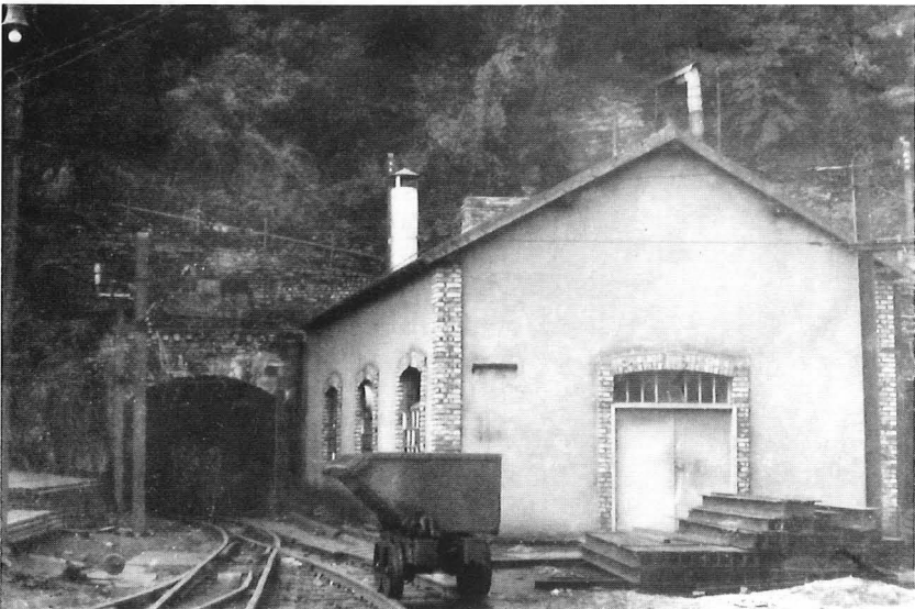
L'entrée de la mine et l'atelier d'affûtage avec son annexe le séchoir de sable.
