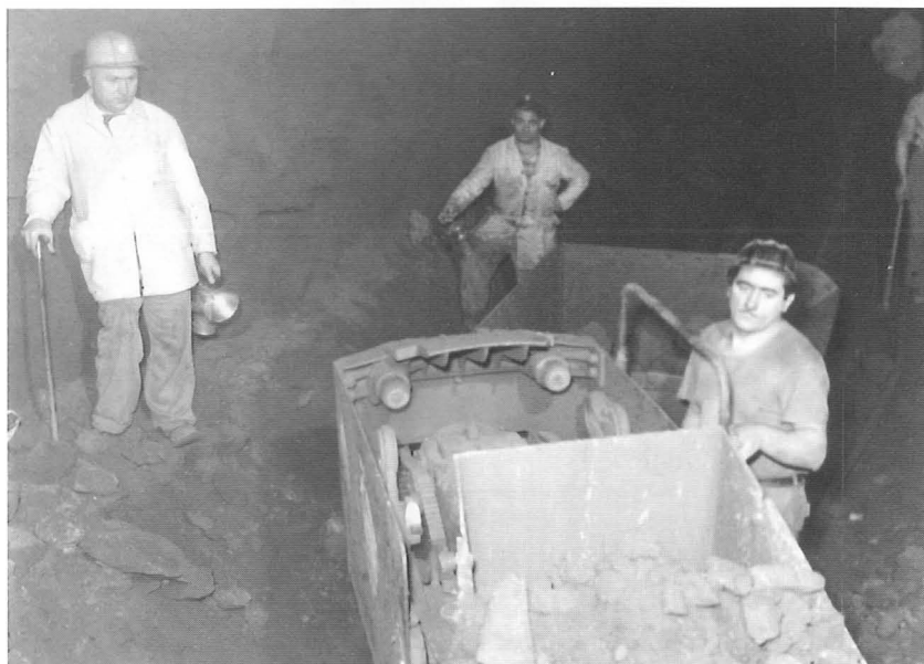
Mine Thillenberg 1950 Chargeur sur Eimco: Janizzi Jos Chef d'exploitation: Orazi E. - en arr.: Pozzachio Minotti.
