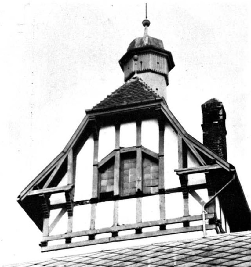
Das Oberteil des Fachwerkfiltrierturmes mit aufgebautem Blitzableiter
