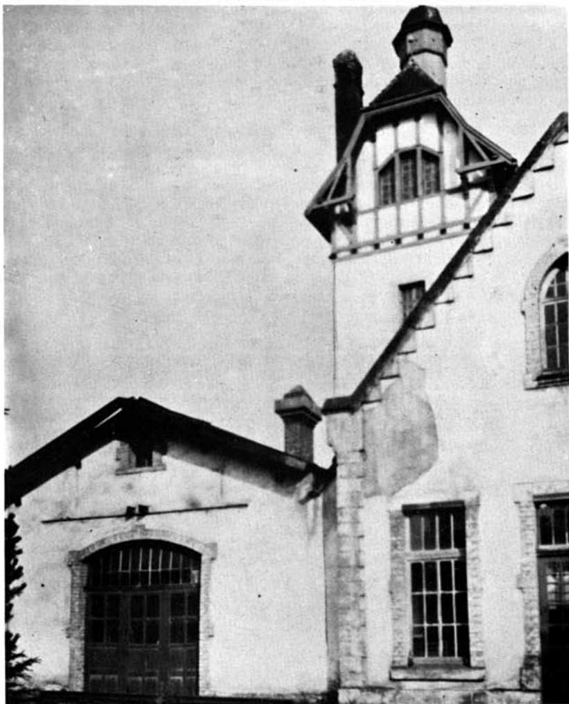
Nach dem Aufbau 1908: Links: Reparaturwerkstatt (8,4 m Front); rechts, die Spül- und Abfüllhalle (8,15 m Front, Tiefe: 14,6 m)
