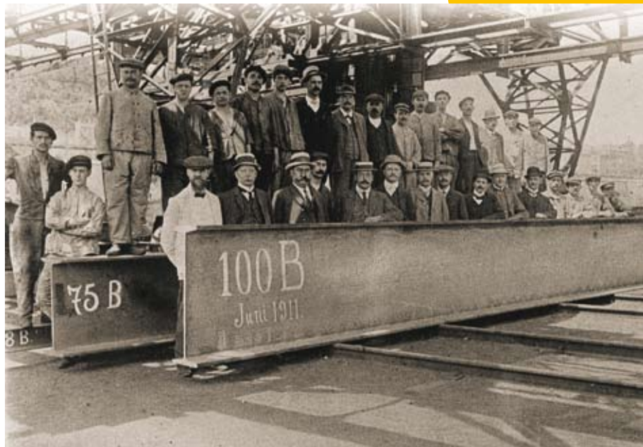
En 1901, l'usine de Differdange est la première au monde à laminier des poutrelles Grey. La première poutrelle de 100 cm quitte l'usine en 1911. © Éditions Guy Binsfeld
